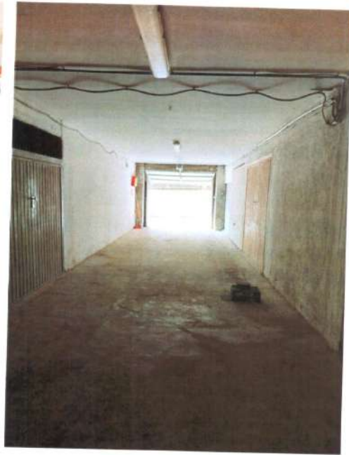
Foto 12 – Tunnel accesso garage
