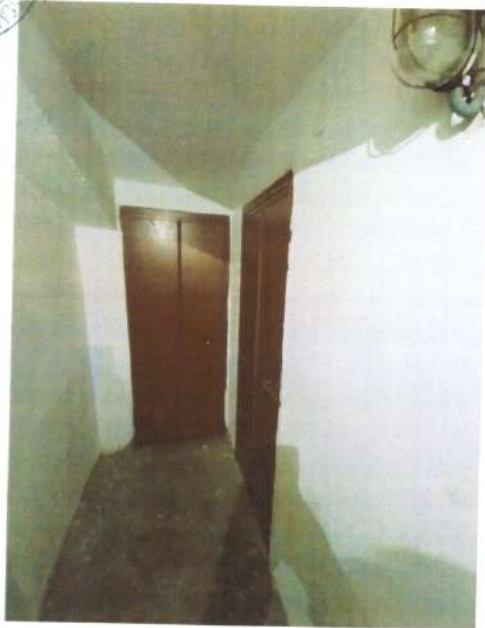
Foto 13 – Accesso ripostiglio sottotetto
